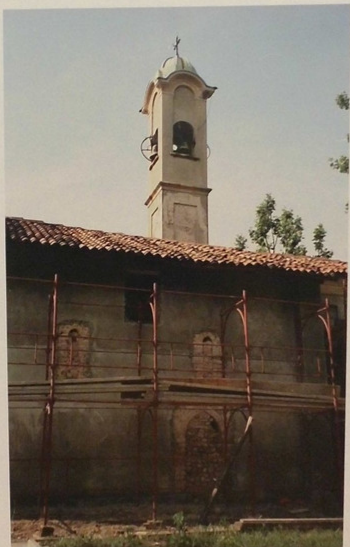
Lavori di restauro esterno: 1992
