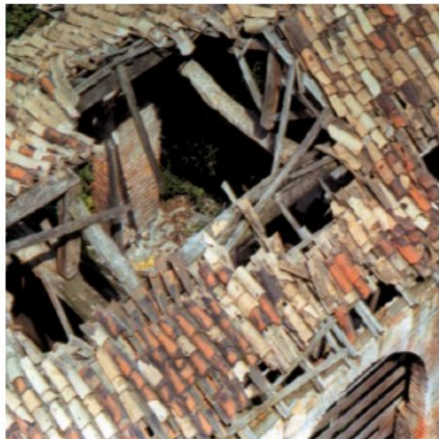
Allegato alla Mappa dei Comuni Censuari di Porta Vercellina – anno 1854 e grave stato di degrado delle coperture in travi di legno e tegole in coppe
