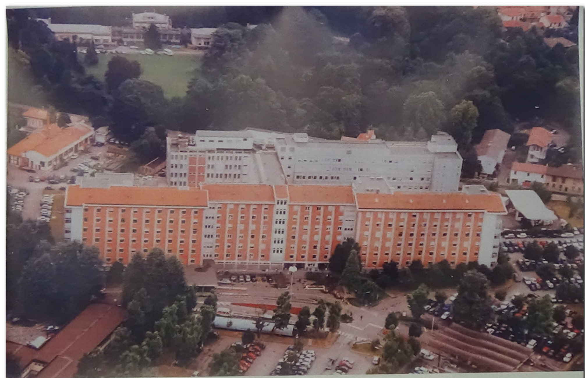
FOTO N° 24. Il Monoblocco completato con il terzo stralcio. Facciata principale.
