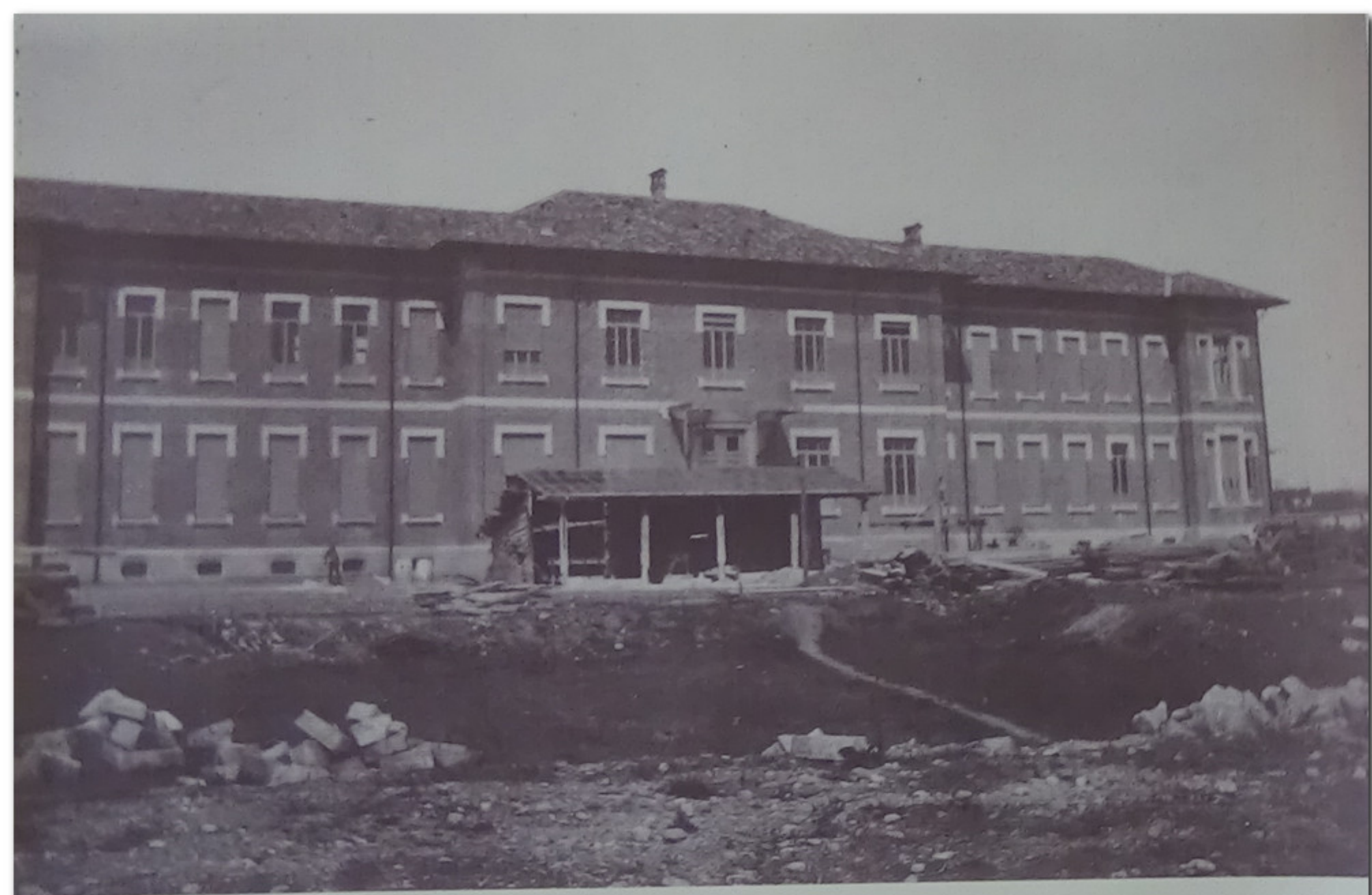
- FOTO N° 4. Aprile 1903 - L'Ospedale ancora in costruzione. -
