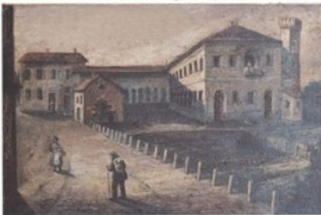
edificio della scuola elementare "Mazzini".
