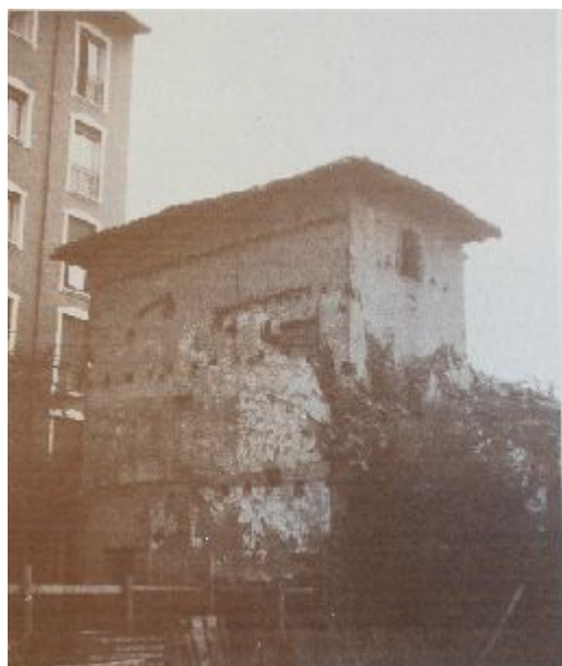
L'edificio prima del restauro
