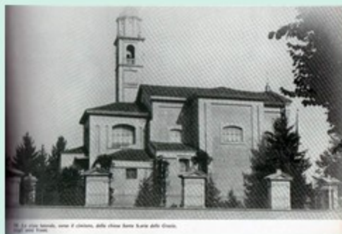
18. Chiesa Sordani, sede il cimitero della chiesa Santa Maria della Grazie. 1898 - 1900
