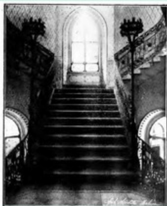
Scale centrali del Palazzo Municipale
