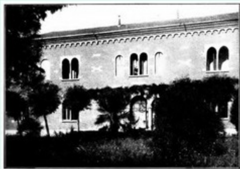
Hotel Salsoglio - facciata verso il giardino (orig. G. Ferrini)
