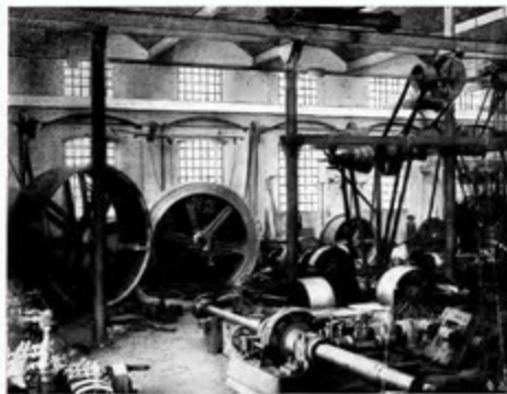
Cilindri meccanici Pratelli Bombaglio (sala di lavorazione)
