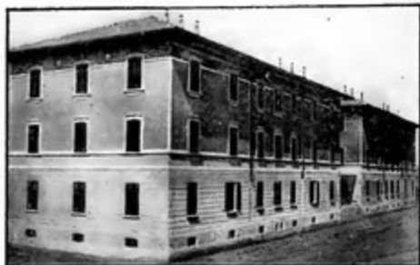
Case operaie del Cottonificio Dell'Acqua Lissoni e Castiglioni
