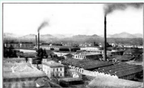
Stabilimento chimico - Estate generale
