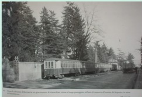
Un treno in partenza dalla stazione su linee nuove di stazione nuova a largo prospetto all'arco di ingresso del deposito, in zona di Lepans.
